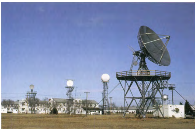
图2 1969年NSSL的10 cm脉冲多普勒天气雷达天线和开放式塔架，发射机位于旁边的机房（右），左边为WSR-57天气雷达
