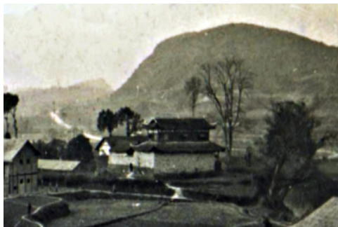
图2 1942年湄潭武汉测候所所址——湄潭玉皇阁 (湄潭浙江大学西迁陈列馆提供)
