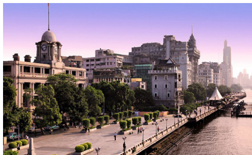
图4 现在的粤海关旧址和西堤码头
