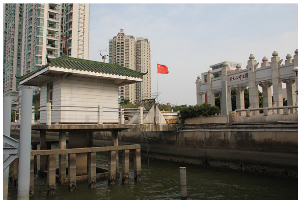
图5 现在中大码头旁的水文站
